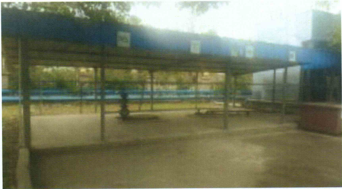
地埋式柴油罐
